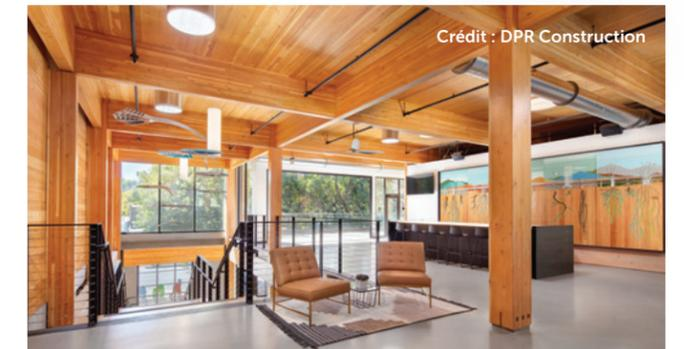
Grâce à l'aide de WoodWorks, DPF construction a ajouté 6000 pieds carrés d'espace à son nouvel espace à bureaux de Sacramento (Californie) l'an dernier. Des poutres de bois lamellé-collé et de CLT ont aidé à concrétiser ce projet rapidement et de compléter la structure en seulement six jours.
